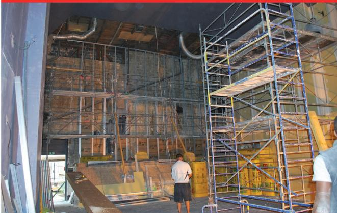
Depuis quelques semaines, le cinéma est en chantier avec des travaux conséquents pour remettre à neuf son unique salle. De nombreuses modifications ont eu lieu notamment au niveau électrique, plomberie mais surtout au niveau acoustique et thermique afin de permettre une meilleure isolation sonore pour le voisinage proche du bâtiment.
