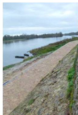
Cale du port de Bertignolles (Savigny-en-V.)
