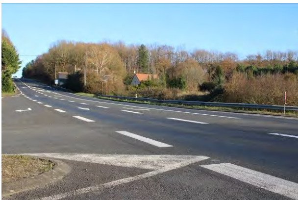
Route départementale 751 à Chinon
