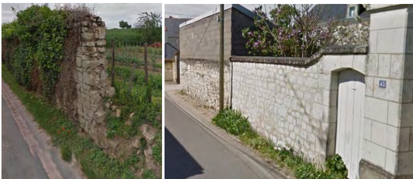
Mur à l'abandon menaçant de s'effondrer à gauche (Candes-St-Martin) et exemple de rénovation de mur de clôture à droite (Savigny-en-Véron)
