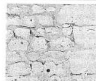
XV—XIX e (1) Maçonnerie de moellons assisés. Chaînage à tuffeau appareillé
