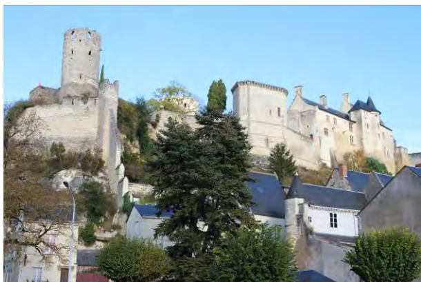
Zone urbanisée de Chinon (château)
